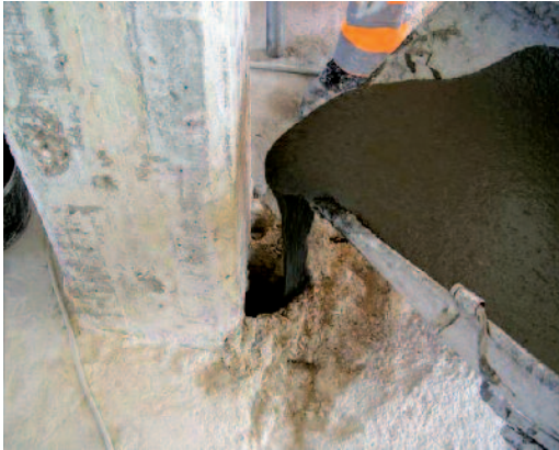
Figura 11 Rinforzo dei pilastri: colaggio del microcalcestruzzo fibrorinforzato mediante foro sul solaio (a sinistra).
