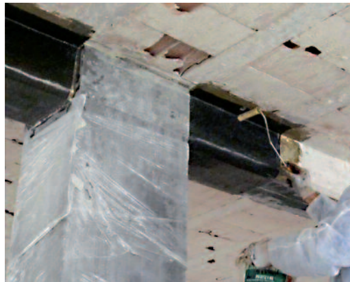
Figura 16 Rinforzo delle travi: puntelli di sostegno posizionati durante le prime fasi di asciugatura della resina (a sinistra).
