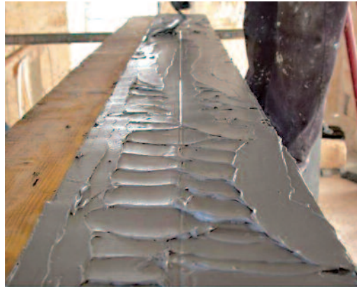
Figura 14 Rinforzo delle travi: stesura del primer epossiamminico sul supporto di calcestruzzo (a sinistra).
