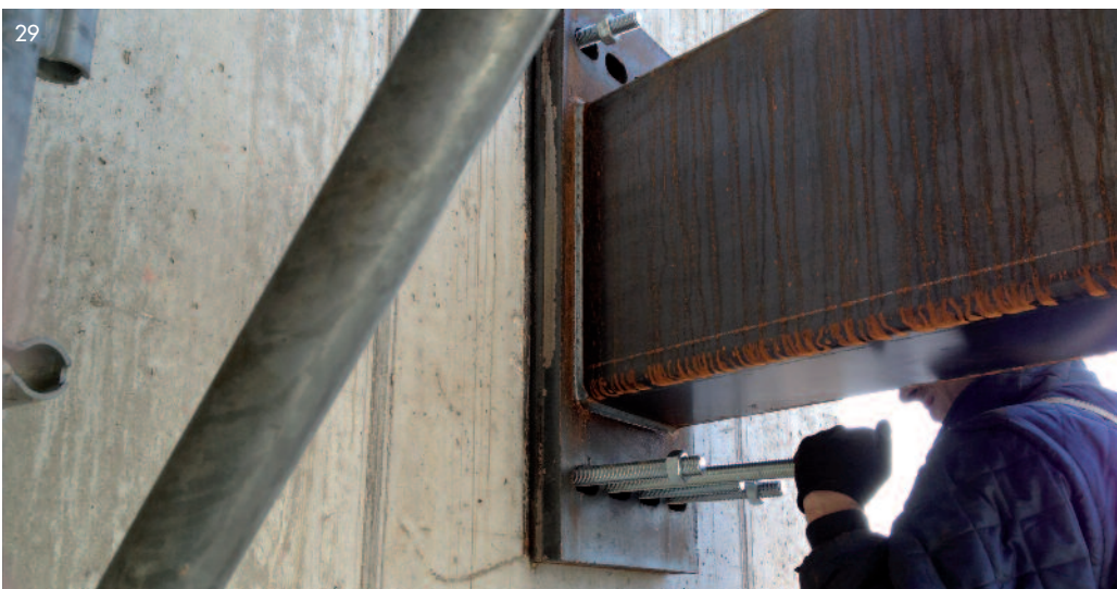
Figura 29 Il fissaggio delle travi ai nuovi pilastri in c.a.
