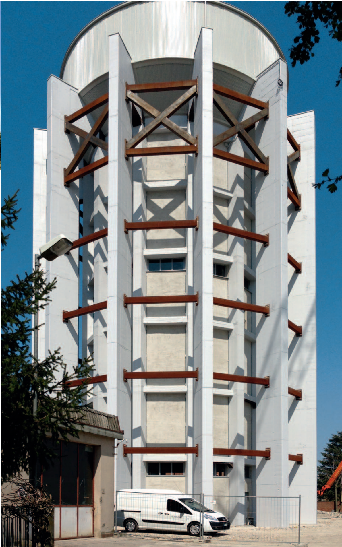
Figura 30 La torre piezometrica di Mirandola, prima e dopo l'adeguamento sismico.
