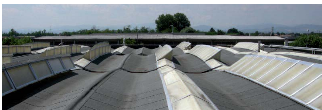
Figura 8 Copertura con tegoli alari.
