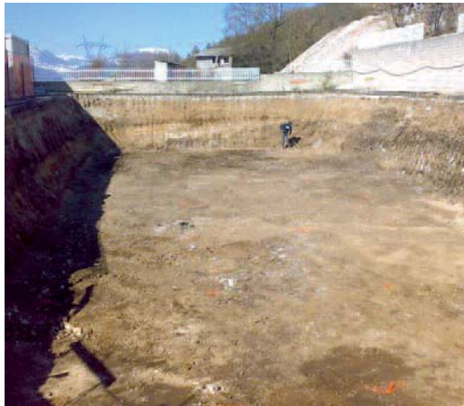
Figura 13 Demolizione degli edifici (a sinistra).
