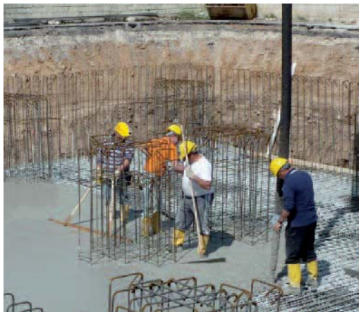
Figura 17 Realizzazione della sottostruttura: getto della platea di fondazione.
