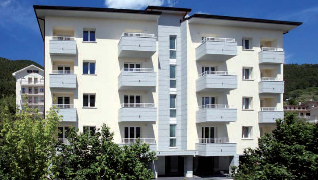
Figura 37 Veduta della facciata completata di un edificio.
