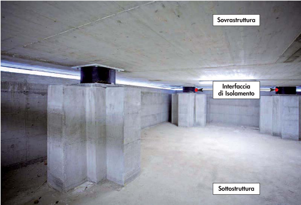
Figura 24 Interfaccia di isolamento completata.
