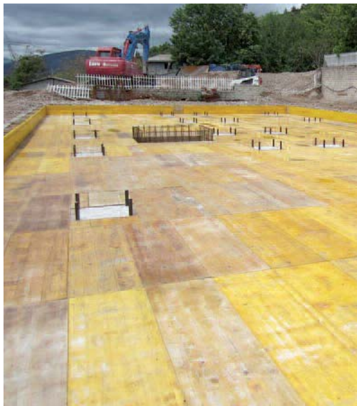
Figura 23 Armatura della platea della sovrastuttura in corrispondenza degli isolatori.
