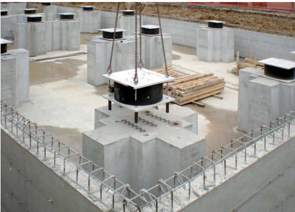
Figura 20 Posa e centraggio degli isolatori.
