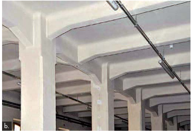
Figura 5 Stato di fatto a) della pilastrata e b) dettaglio degli orizzontamenti.
