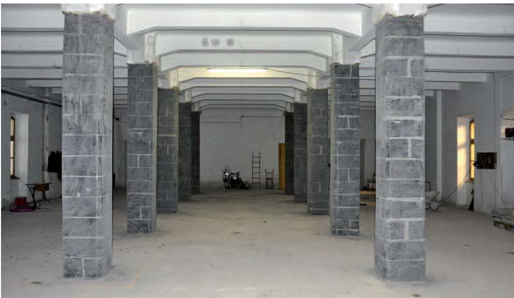
Figura 14 Sistema di rinforzo dei pilastri completato.
