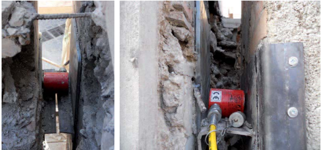
Figura 8 Martinetto idraulico per la spinta dell'arco non rinforzato.
