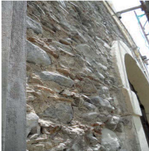
Figura 2 Arco oggetto di studio: stato di fatto (a sinistra).
