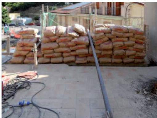
Figura 6 Posa in opera dell'intonaco (a sinistra).
