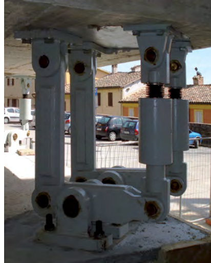
Figura 42 Particolare manovellismo meccanico base torri.
