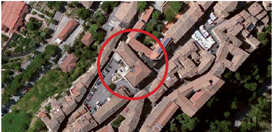
Figura 5 Vista aerea ed ubicazione del fabbricato.
