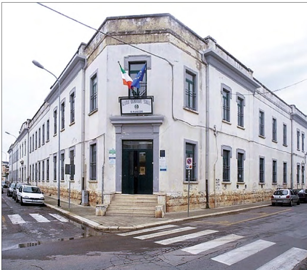
Figura 1 Edificio scolastico "Guglielmo Marconi" a Casamassima (BA).
