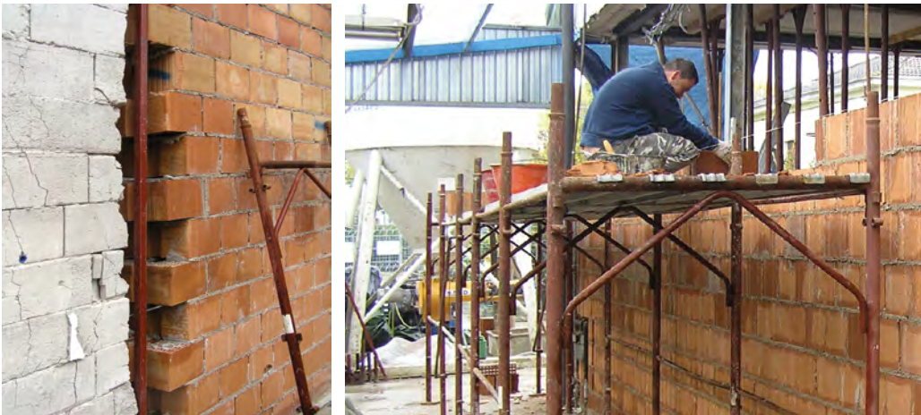
Figura 18 Fasi di demolizione/ricostruzione delle murature del piano terra con muratura armata Poroton®.
