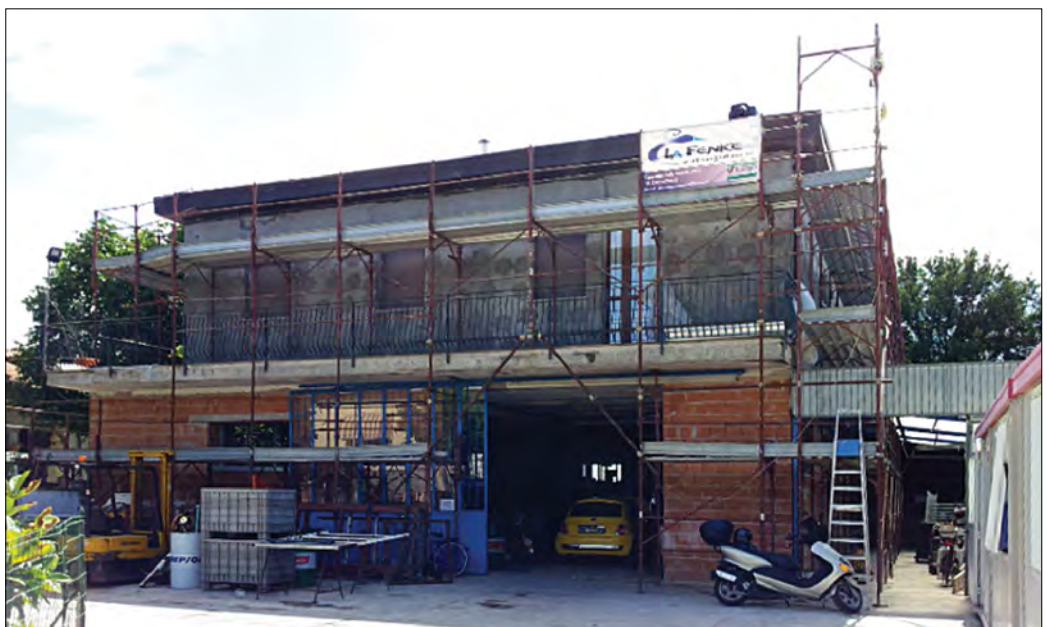
Figura 21 Fine degli interventi di riparazione e miglioramento strutturale.
