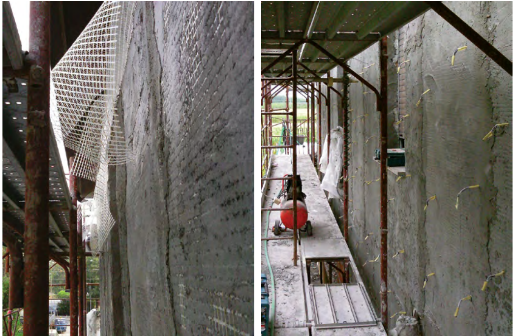
Figura 20 Fasi di applicazione dell'intonaco armato in fibra di vetro (sopra) e del "collare" in fibra di carbonio (sotto).
