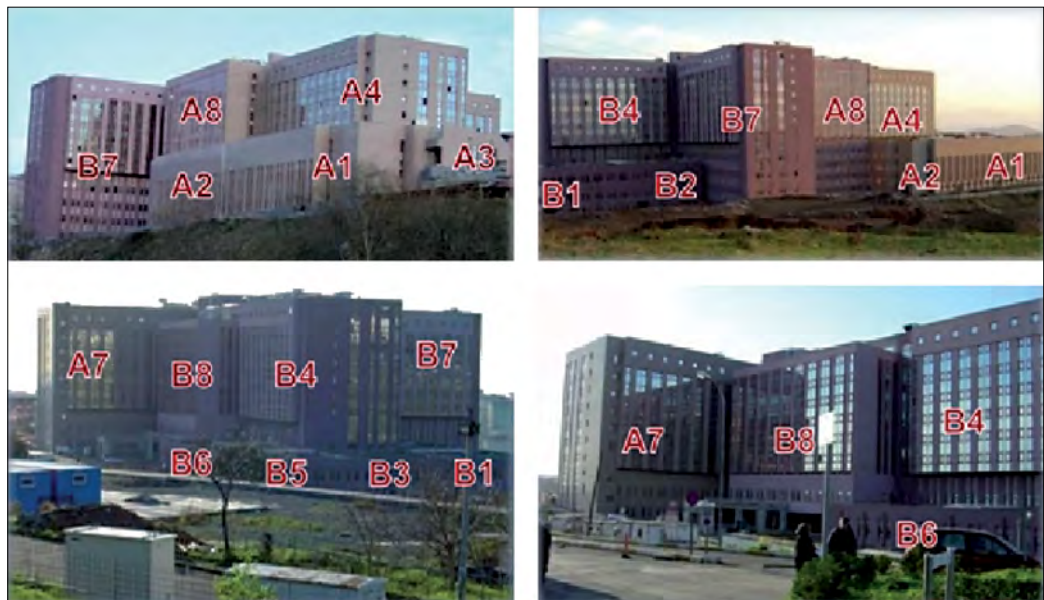
Figura 2 Viste dell'edificio con indicazione dei diversi blocchi.
