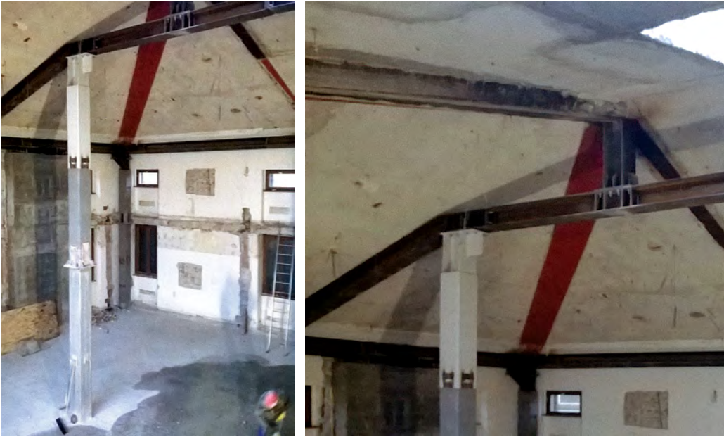
Figura 13 Posa dei profili di rinforzo in acciaio delle coperture secondo i nuovi schemi di progetto con appoggio sulle nuove strutture verticali realizzate.
