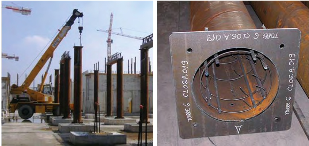
Figura 10 Esempi di pilastri PDTI NPS.
