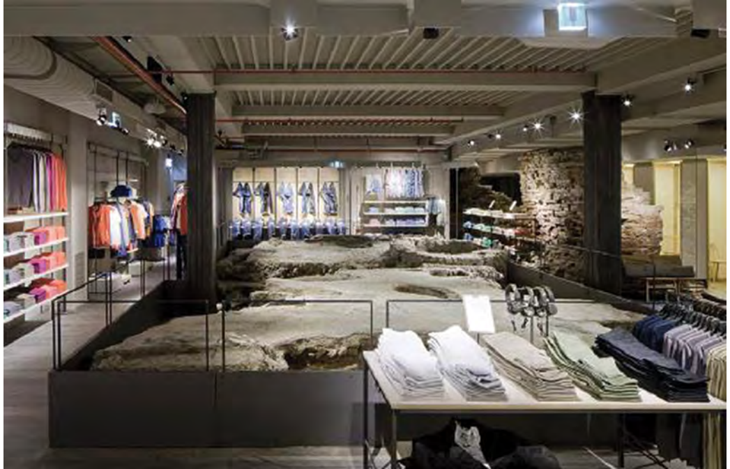
Figura 25 Una foto dell'interno del Megastore Benetton: per scelta della committenza sono stati lasciati a vista gli elementi del sistema costruttivo NPS, i pilastri PDTI, le travi NPS Basic e il solaio in lamiera grecata NPS L.
