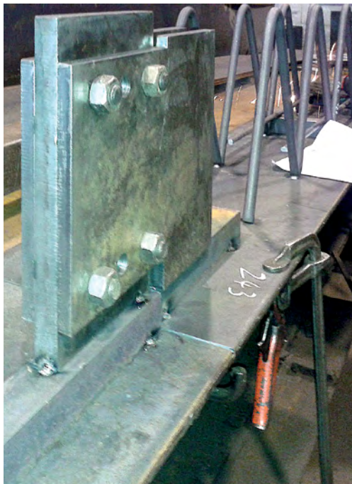
Figura 22 La limitazione di lunghezze e pesi, ha determinato la necessità di realizzare giunzioni mediante bullonature, con flange e fazzoletti di rinforzo.
