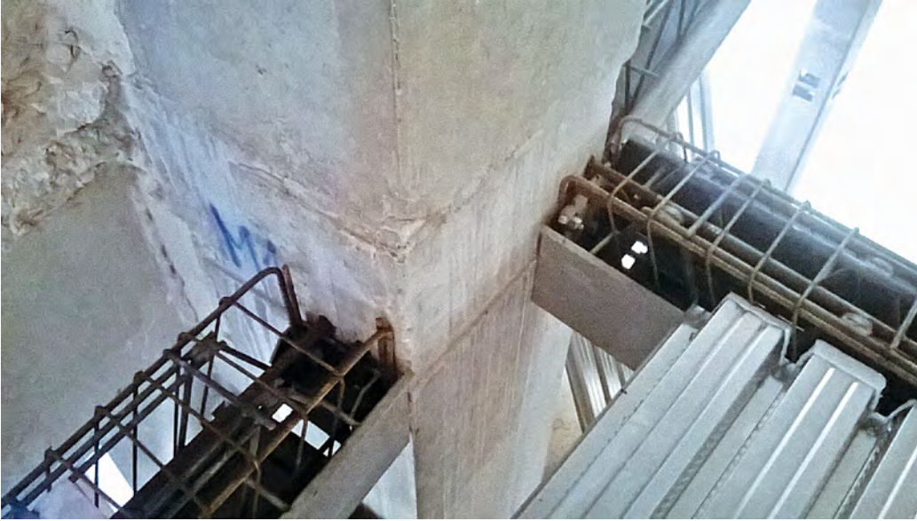
Figura 23 Tipico nodo pilastro- orizzontamento.
