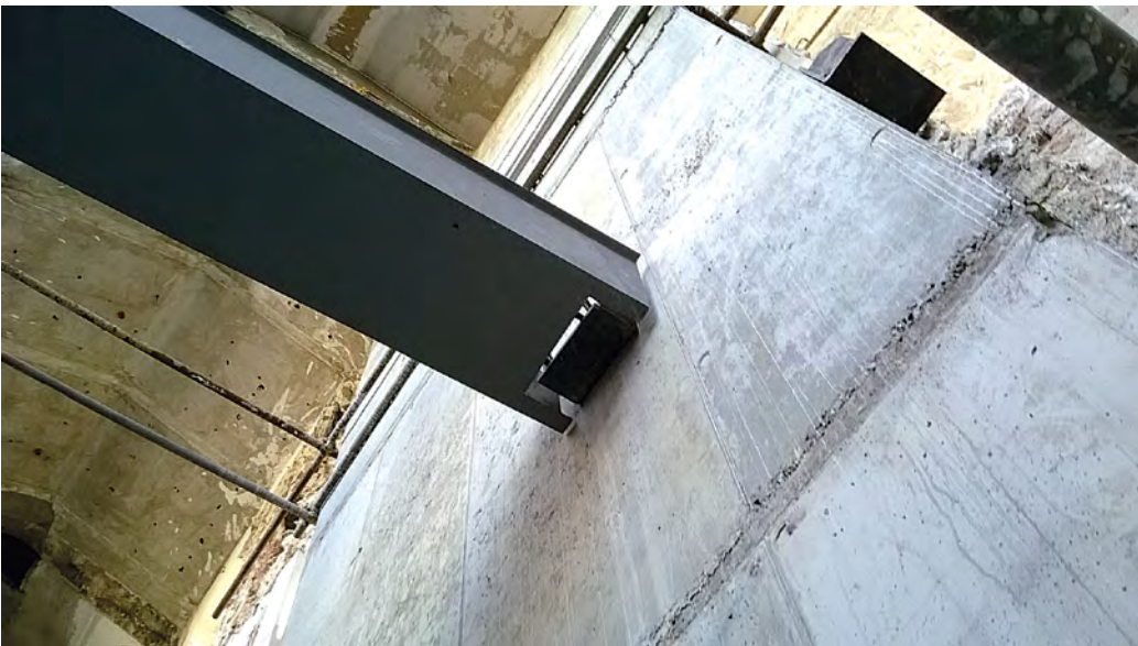
Figura 24 In corrispondenza degli appoggi previsti sui setti in c.a. sono state previste apposite "tasche" di alloggiamento delle estremità delle travi, in corso d'opera sostituite da mensole metalliche e tasselli di fissaggio.
