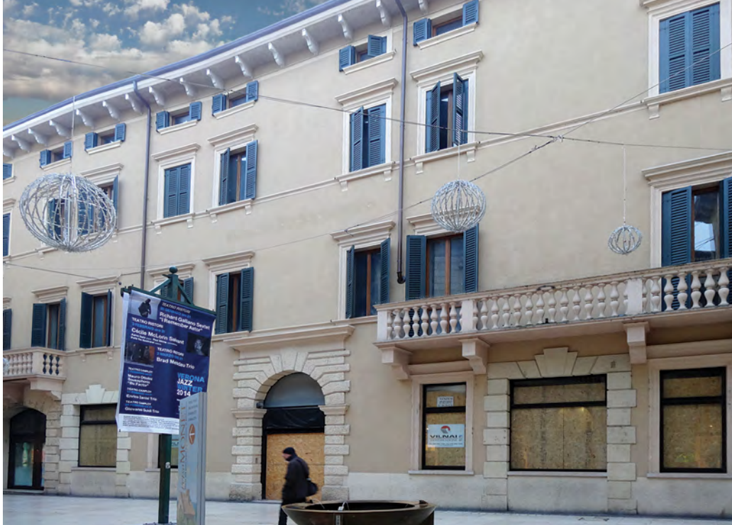
Figura 7 Allo stato attuale, la struttura è costituita da pareti storiche perimetrali in mattoni pieni, su cui si innestano a vari livelli i solai in latero cemento gettati in opera. Nella parte centrale sono presenti pilastri in c.a. debolmente armato e colonne cave ornamentali in pietra riempite di calcestruzzo. La copertura a falde è realizzata con le stesse tecniche costruttive.
