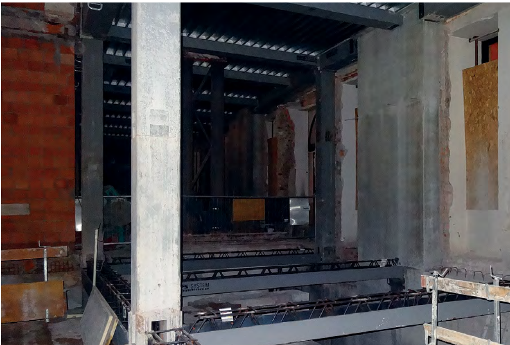
Figura 20 I vincoli progettuali e logistico/cantieristici volgevano a schemi strutturali in cui era necessario minimizzare il numero degli elementi verticali: la soluzione adottata ha previsto solo 6 pilastri centrali per sorreggere solai di 700 m 2 di superficie per 5 piani, al netto dei setti), con conseguente necessità di utilizzare orditure di travi principali e secondarie di luce elevata.
