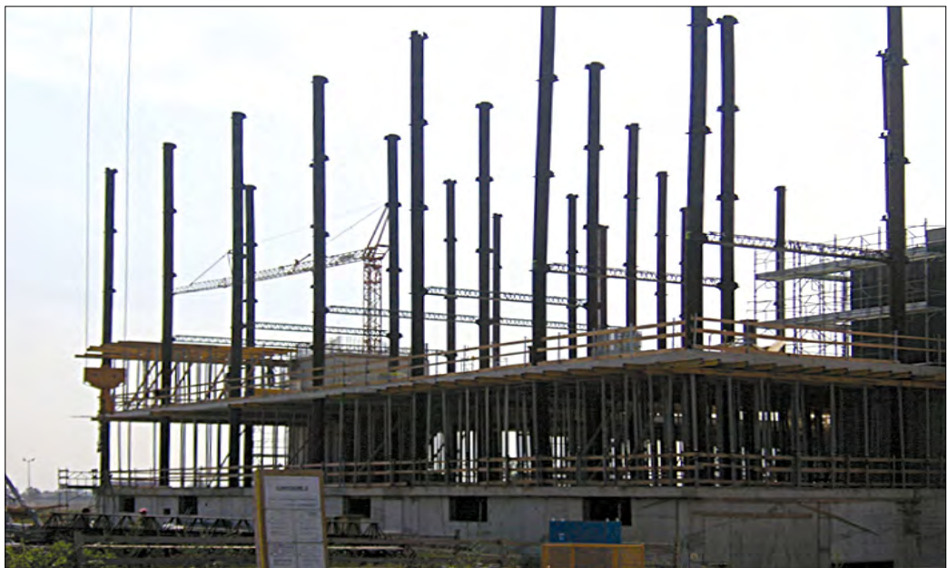
Figura 1 Esempio di utilizzo della tecnologia NPS in costruzioni ex-novo.
