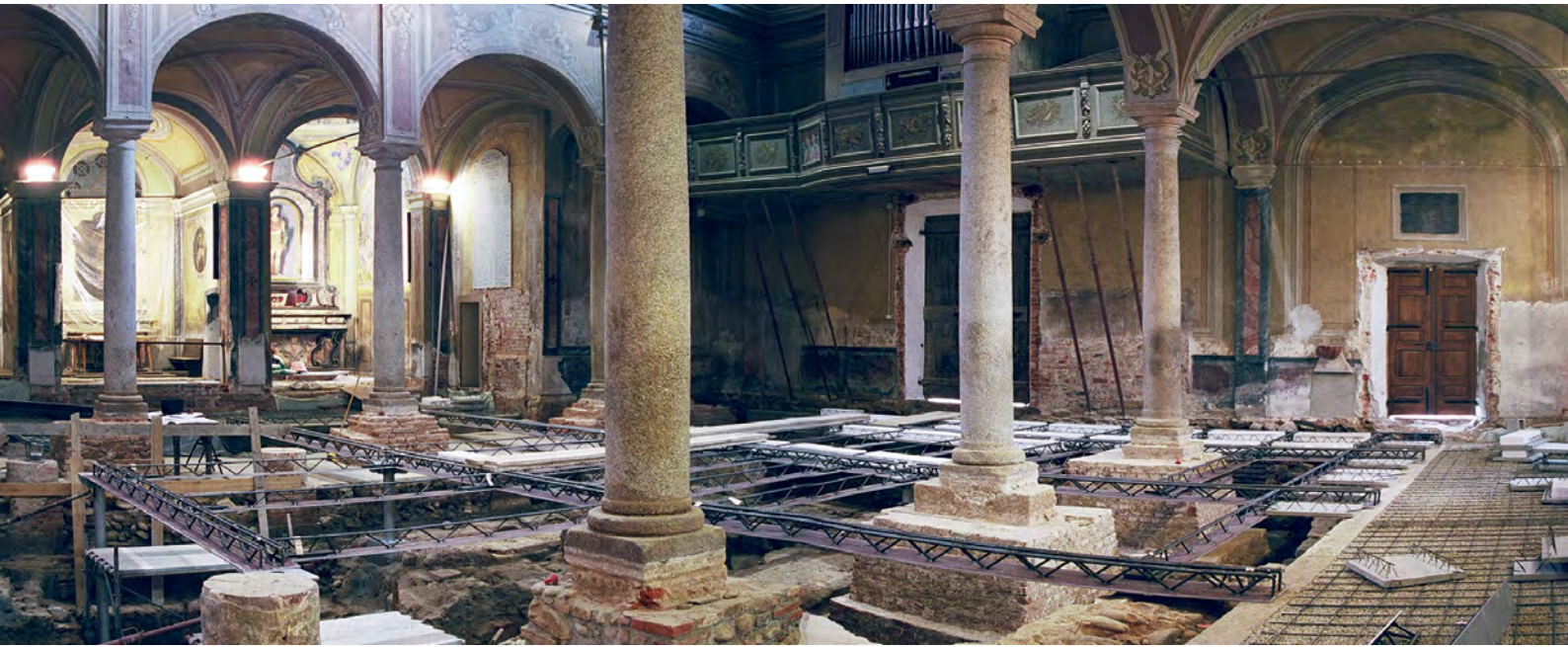
Figura 2 Esempio di utilizzo della tecnologia costruttiva NPS un'intervento di recupero della Chiesa di Sizzano (NO).
