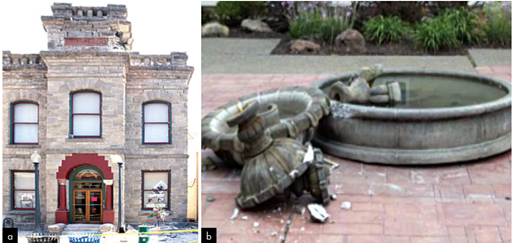
Figura 21 a) Collasso di un parapetto in muratura presso la Goodman Library; b) Collasso di una fontana in pietra presso la Justin-Siena High School. (Kang and Mahin 2014).
