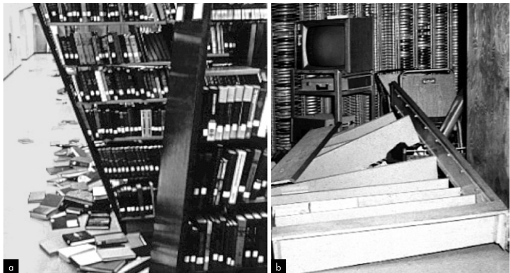
Figura 3 a) Danni agli scaffali nella San Fernando Valley State College Library; b) Altri danni alle librerie nella San Fernando Valley State College Library. (Committee on the Alaska Earthquake, 1973).
