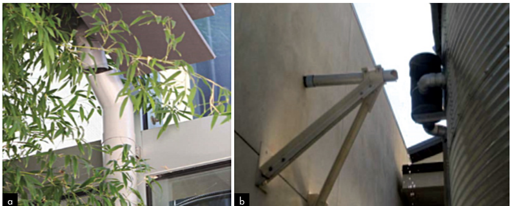
Figura 22 a) Collasso dell'ancoraggio di un serbatoio presso una scuola di Napa; b) Tubazioni dislocate presso il Napa Valley College. (Kang and Mahin 2014).
